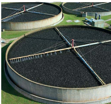
Slika 102. Proces biološkog tretmana sa fiksiranim rastom (a-1) šematski i (a-2) pregled kapajućeg filtra sa kamenom ispunom; i (b-1) šematski i (b-2) pregled pokrivenog tornja kapajućeg filtra sa plastičnom ispunom.
